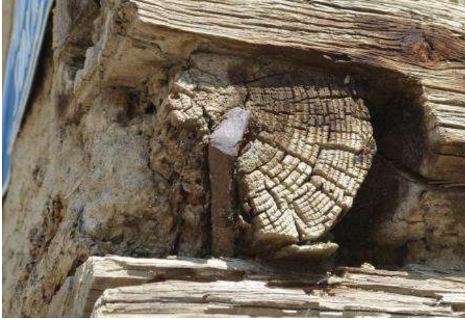
Görsel 10. Taşıyıcı sistemde kullanılan dövülerek yapılmış çiviler
