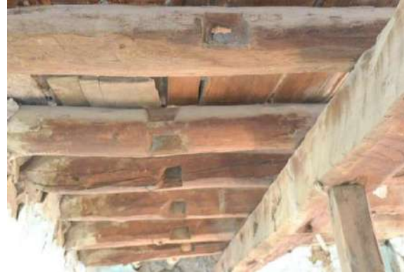
Görsel 2. Halat bağlayıp sürüklemek için açılmış delikler
