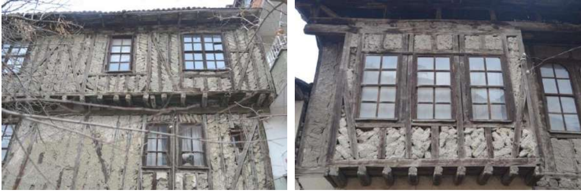
Görsel 17 Kerpiç dolgu çatkı duvarlar
