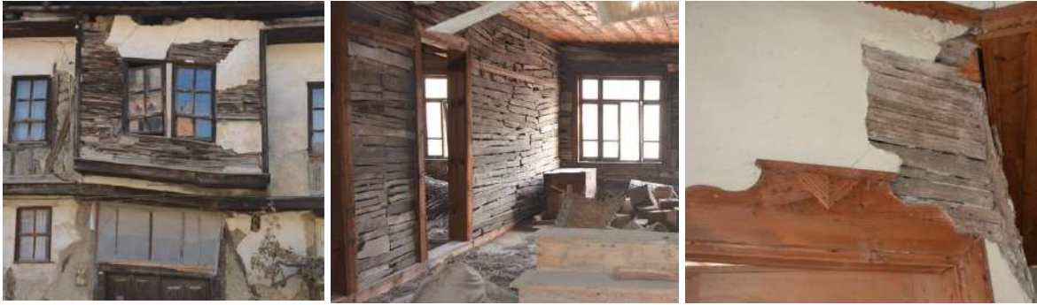
Görsel 18. Bağdadi tekniğiyle yapılan duvar örnekleri
