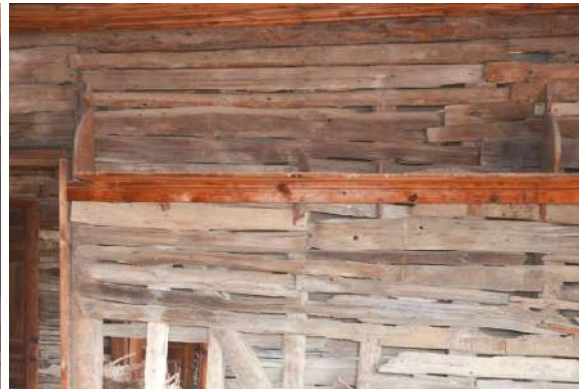
Görsel 22. Duvarlarda sıva payı için yatay yerleştirilmiş tahtalar askılık ve raf olarak da kullanılır.
