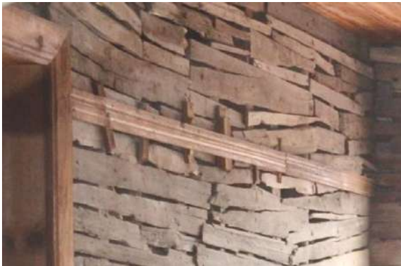
Görsel 22. Duvarlarda sıva payı için yatay yerleştirilmiş tahtalar askılık ve raf olarak da kullanılır.
