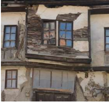
Görsel 18. Bağdadi tekniğiyle yapılan duvar örnekleri
