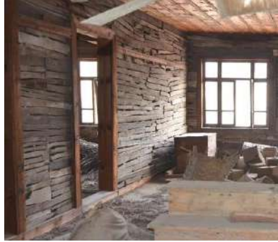
Görsel 18. Bağdadi tekniğiyle yapılan duvar örnekleri
