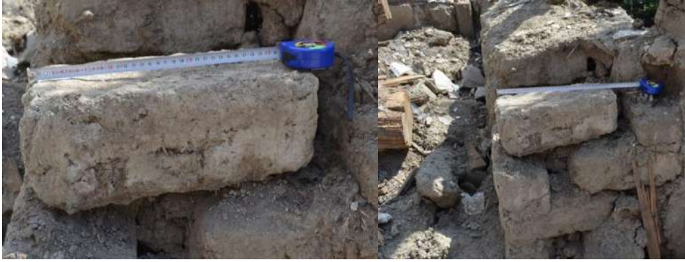
Görsel 3. Yığma duvar olarak kullanılan ana kerpiç
