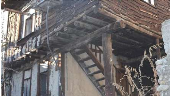
Görsel 16. Üst katı taşıyan ana kirişler, kat kirişleri ve direk
