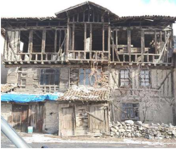
Görsel 14. Ağaç çatkı duvarlar
