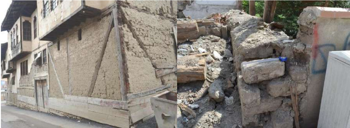
Görsel 13. Seyrek çatıklar arasında kullanılan kalın, yığma kerpiç duvar
