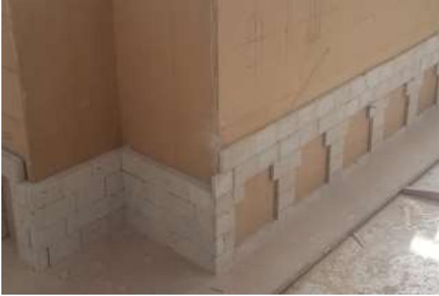
Görsel 3. Gökmedrese minyatür yapım aşamaları (Korkmaz, 2022)
